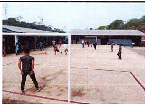
Foto 4: CONSTRUCCION Y SUMINISTRO DE LOSA DE CONCRETO, CANCHA POLIDEPORTIVA
