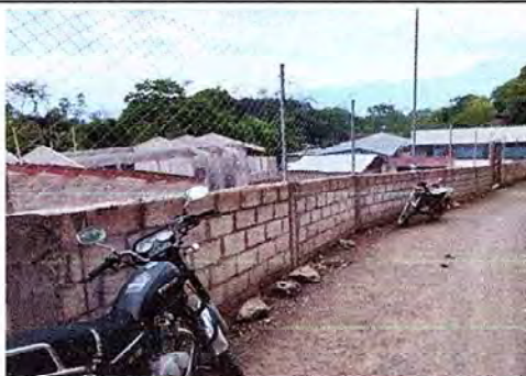
Foto 1: CONSTRUCCION Y SUMINISTRO DE MURO PERIMETRAL
