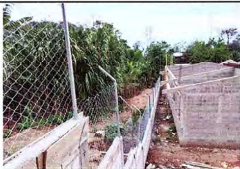
Foto 3: CONSTRUCCION Y SUMINISTRO DE MURO PERIMETRAL
