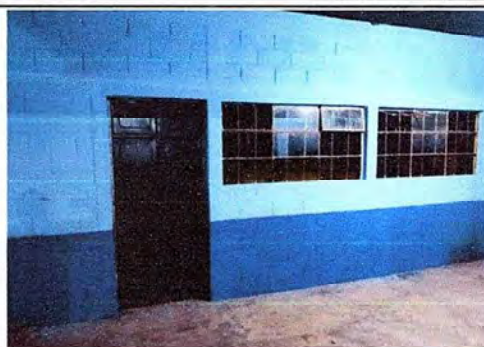
Foto 2: PINTURA EN MURO INTERIORES Y EXTERIORES (DOS MASNOS)
