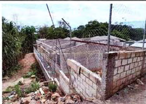
Foto 2: CONSTRUCCION Y SUMINISTRO DE MURO PERIMETRAL
