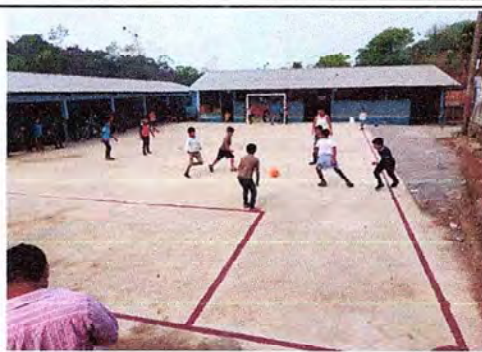
Foto 2: CONSTRUCCION Y SUMINISTRO DE LOSA DE CONCRETO, CANCHA POLIDEPORTIVA
