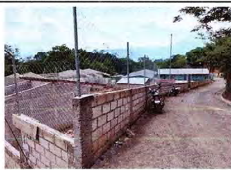
Foto 4: CONSTRUCCION Y SUMINISTRO DE MURO PERIMETRAL
