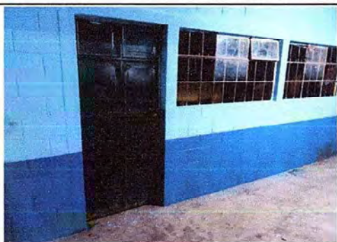
Foto 1: MODULO 4; SUSTITUCION DE PUERTA DE METAL.
