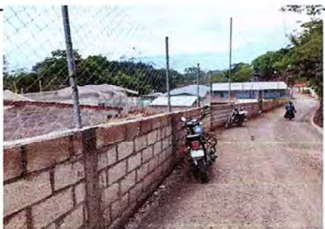
Foto 5: CONSTRUCCION Y SUMINISTRO DE MURO PERIMETRAL
