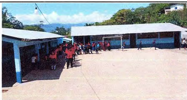
Foto 5: CONSTRUCCION Y SUMINISTRO DE LOSA DE CONCRETO, CANCHA POLIDEPORTIVA
