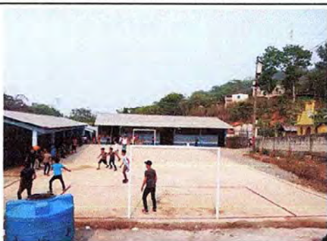
Foto 1: CONSTRUCCION Y SUMINISTRO DE LOSA DE CONCRETO, CANCHA POLIDEPORTIVA.
